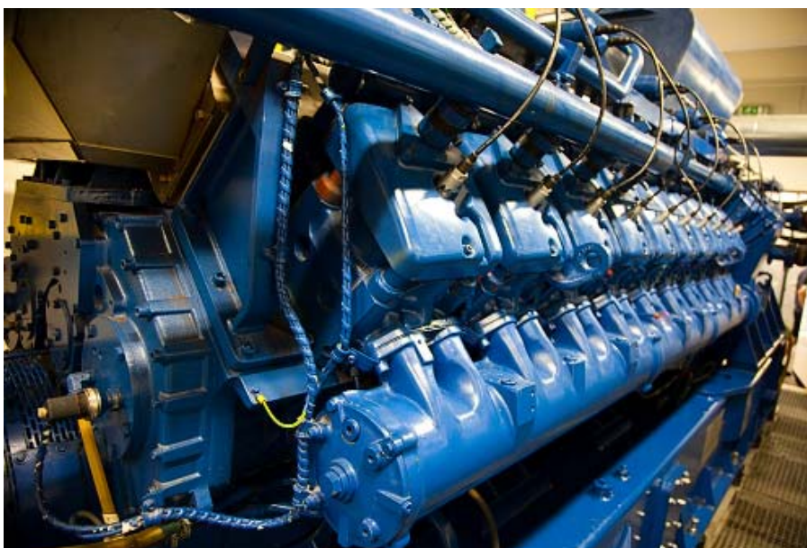
Obr. 2 Pístový spalovací motor MWM (dříve Deutz) TCG 2020 V20 – Výkon 1946 kW e , kogenerační jednotka Rychvald 2.
