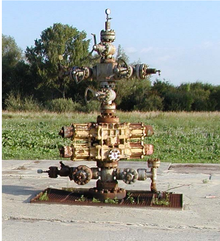
Obr. 3 Sonda uzatvorená a zabezpečená dvojitým hydraulickým preventrom.
