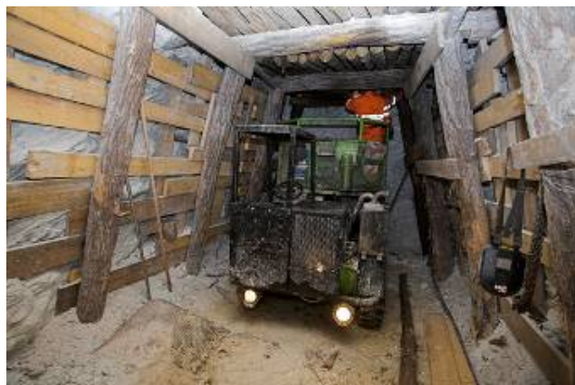
Obr. 6 Dobývková chodba - budovanie výstuže.
