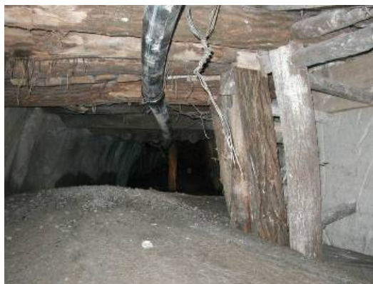
Obr. 11 Doprava cementu do dobývacieho priestoru.
