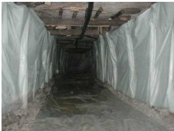
Obr. 9 Špeciálna fólia na bokoch dobývacieho priestoru.
